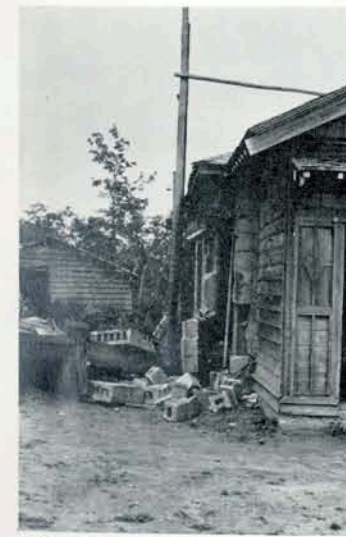
写真 9. びるわ開拓地 神氏宅のブロック崩壊
