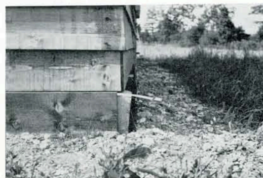
写真 4. 教員住宅の土台ずれ
