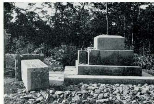
写真 5. 墓石の転落（第7図で示した墓石）
