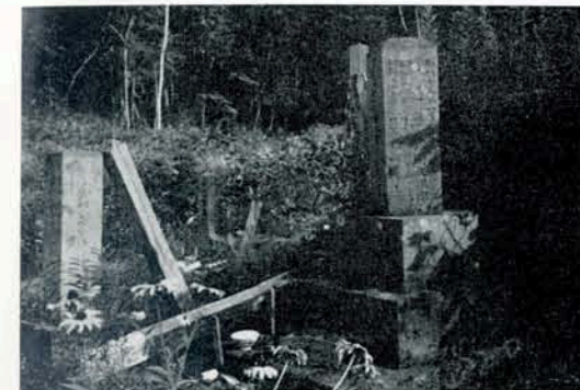
写真 7. 墓石の回転（第10図で示した墓石）
