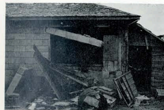
写真 8. びるわ開拓地 神氏宅のブロック崩壊（札幌 横山技官撮影）
