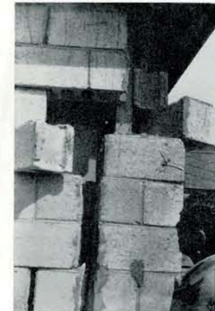
写真 11. 梅村氏宅ブロックの崩壊（NHK 釧路放送局提供）
