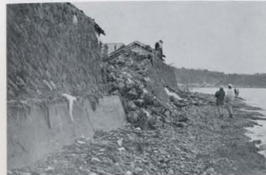
青森県深浦町北金ヶ沢字関 地震による護岸倒壊 (深浦測候所)
