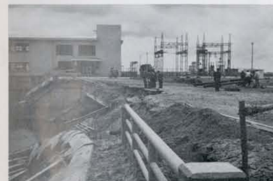
秋田県南部排水機場付近の堤防の破損、排水機 場には被害がない。
